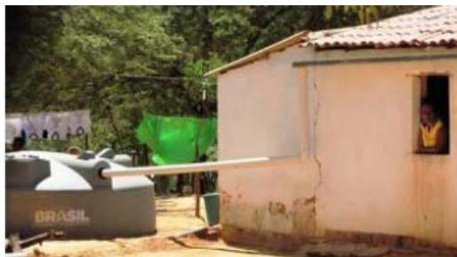
Cisternas: Cada cisterna de polietileno tem a capacidade de armazenar 16 mil litros d'água.
